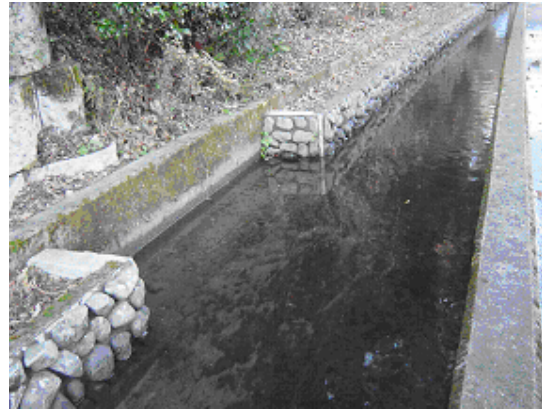
写真7 朝倉用水に設けられた側溝 蛍の幼虫を保護するために設けられたと思われる。
