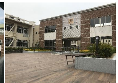
屋上庭園から見る渡り廊下
