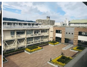
屋上庭園の全景
