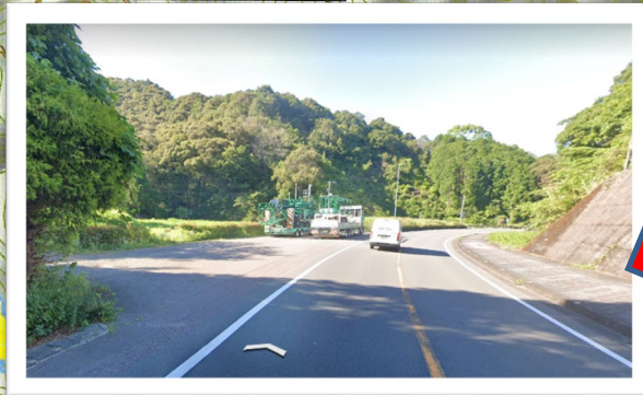
逢坂トンネル出口
