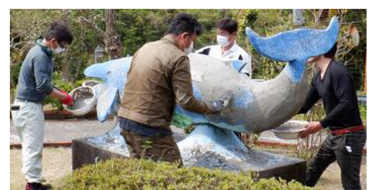
④ 剥がれた部分、ひび割れている部分にセメントを塗りこんでいきます。
