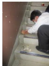
【写真2】蓄光テープの活用
