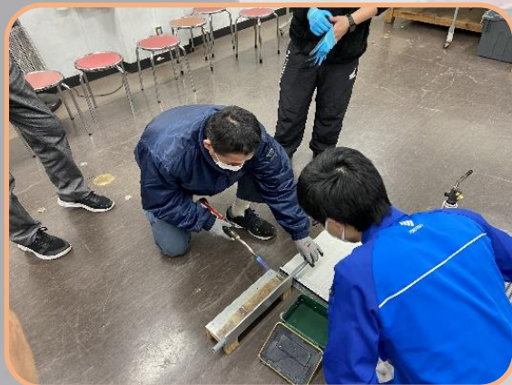
【樹脂管加工】:熱を加え樹脂管を柔らかくし曲げます
