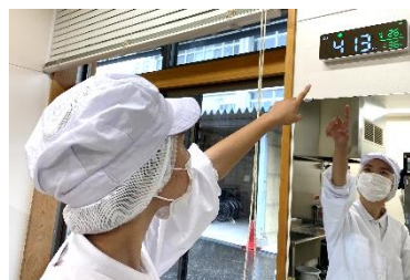
二酸化炭素濃度測定器により、厨房内の換気状況を確認します。
