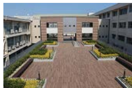
屋上庭園広場(西側から)
