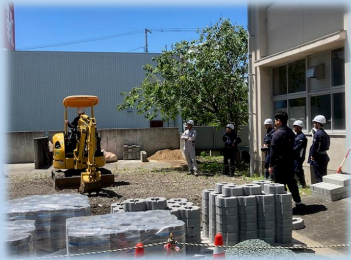
校内施工実習
