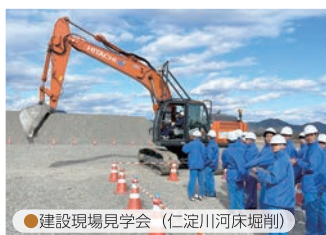
●建設現場見学会（仁淀川河床堀削）
