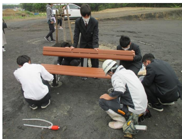
ベンチの設置の様子
