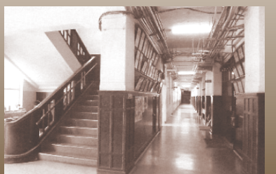
本館1階 中央階段付近
