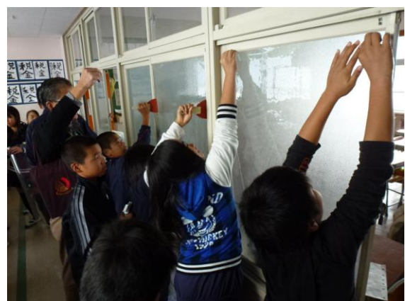
ガラス飛散防止フィルム貼り
