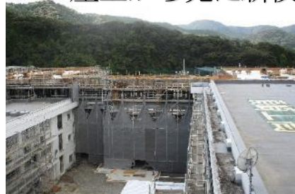
屋上から見た新校舎
